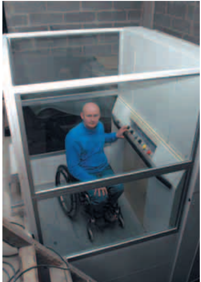
Hissi asennettiin heti kun vesikatto oli päällä.
